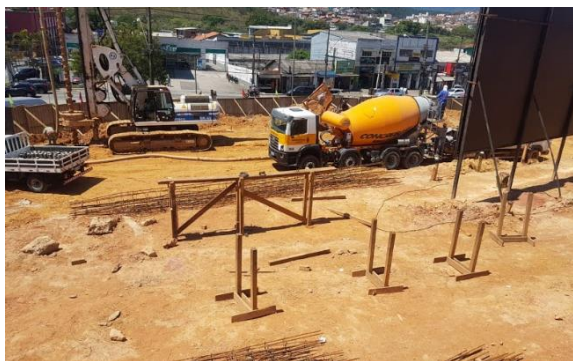
Figura 30 - Estocagem das Armaduras no Canteiro
