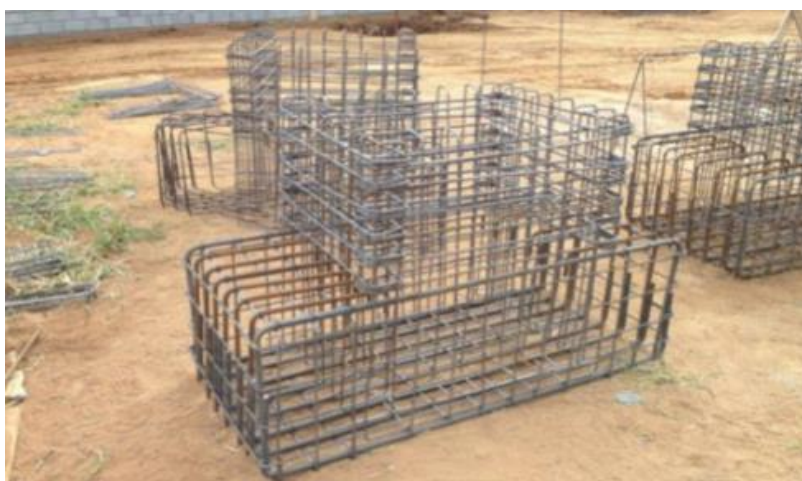
Figura 16 - Armadura pré-montada de um Bloco de Fundação
