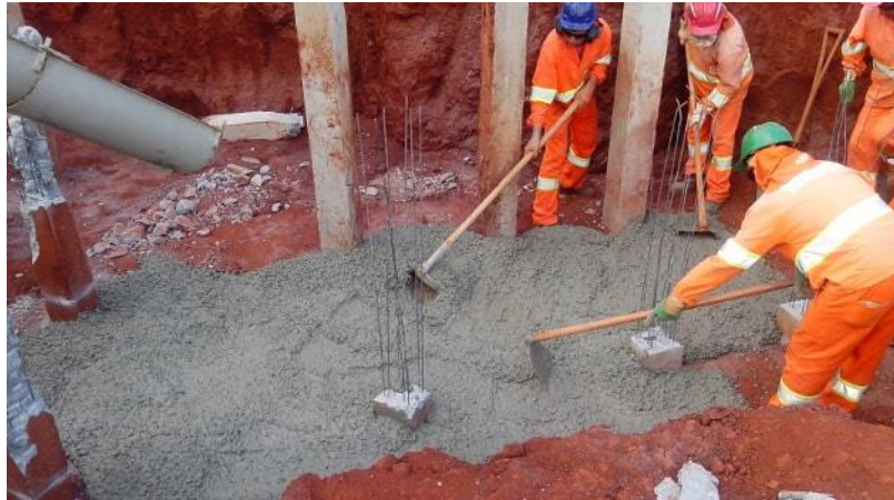
Figura 14 - Execução do Concreto Magro
