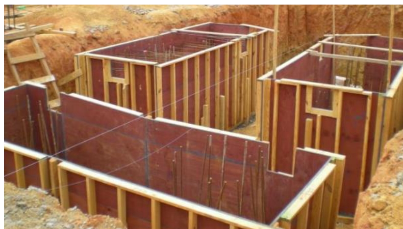
Figura 15 - Posicionamento das formas dos Blocos de Fundação
