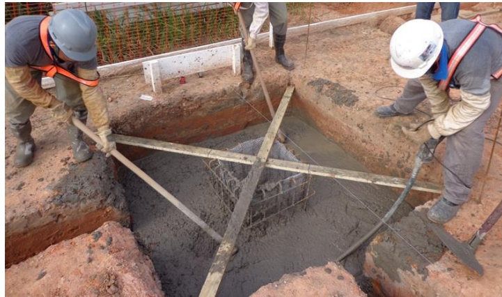
Figura 17 - Concretagem do Bloco de Fundação
