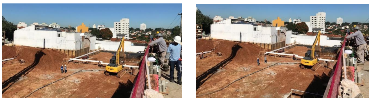
Figura 26 - Transporte das Armaduras dentro do Canteiro de Obras
