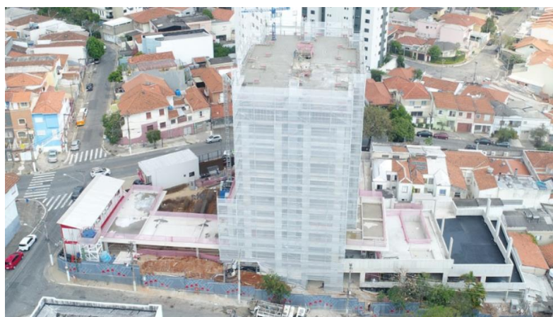
Figura 21 - Vista Aérea do Canteiro de Obras
