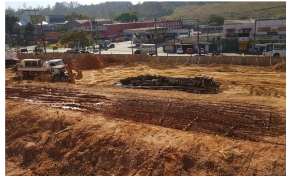
Figura 31 - Estocagem das Armaduras no Canteiro
