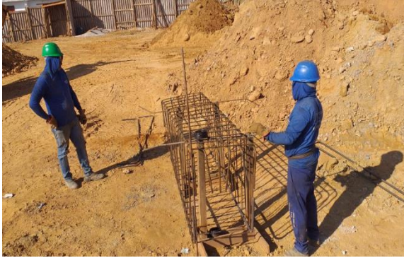
Figura 31 - Estocagem das Armaduras no Canteiro
