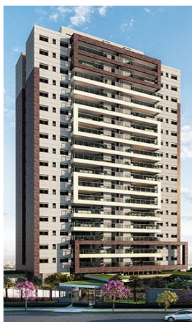
Figura 20 - Imagem da Fachada - Projeto Apogee
