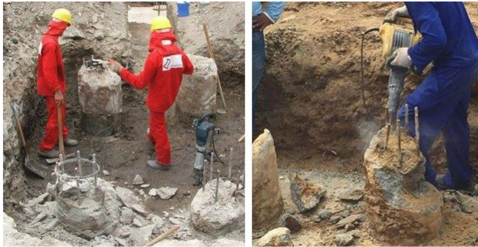
Figura 13 - Processo de Arrasamento das Estacas
