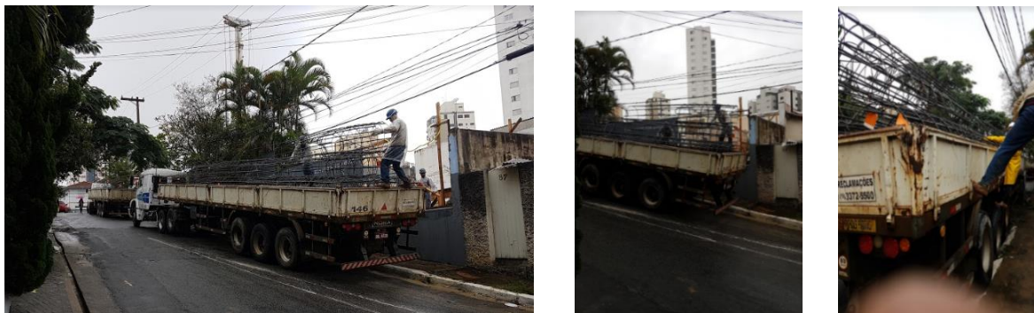
Figura 23 - Recebimento das Armaduras no Canteiro de Obras
