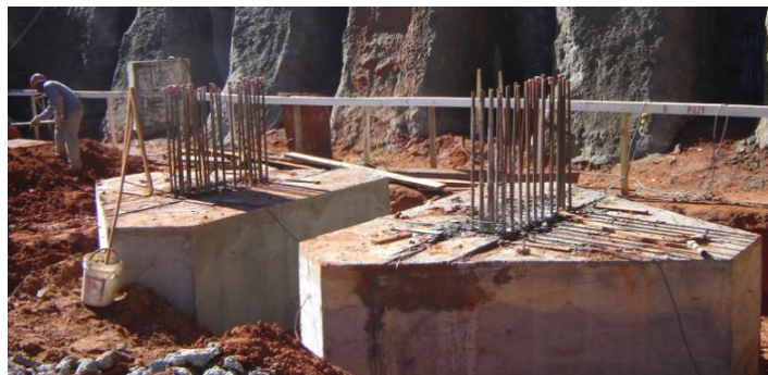
Figura 18 - Blocos de Fundação finalizados
