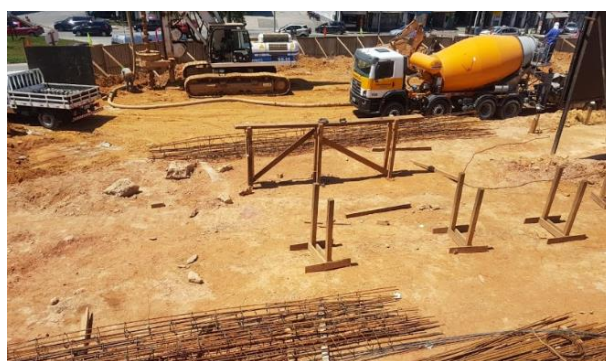
Figura 30 - Estocagem das Armaduras no Canteiro
