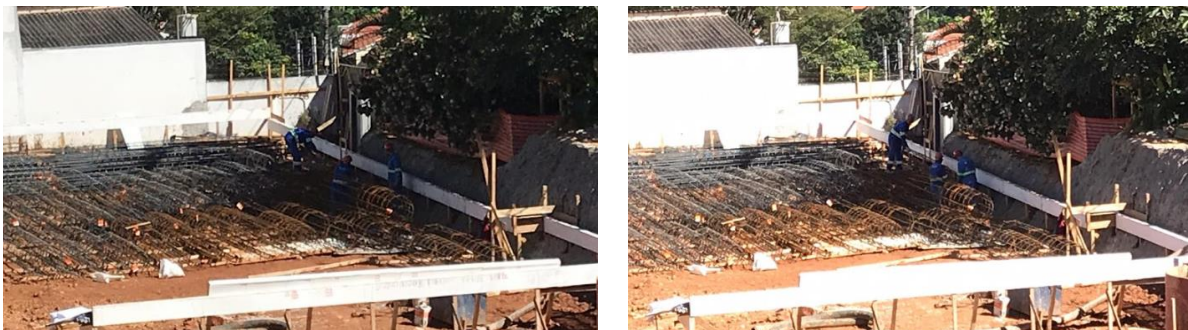
Figura 25 - Estocagem da Armadura no Canteiro
